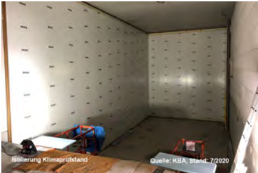
Isolierung des Klimaprüfstands
