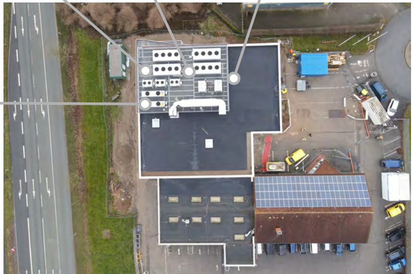
Neubau des Abgaslabors im schleswig-holsteinischen Harrislee
