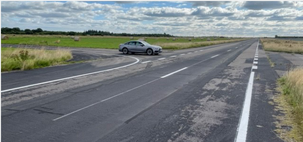
Fahrbahnmarkierung einer Auffahrt zur Schnellstraße zwecks Prüfung des Fahrzeugverhaltens in Abbiegesituationen und auf Landstraßen (Quelle: KBA)
